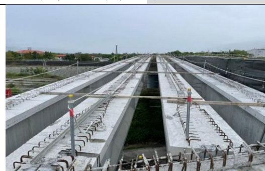
照片 8：吊放後-木料角材橫向連結
