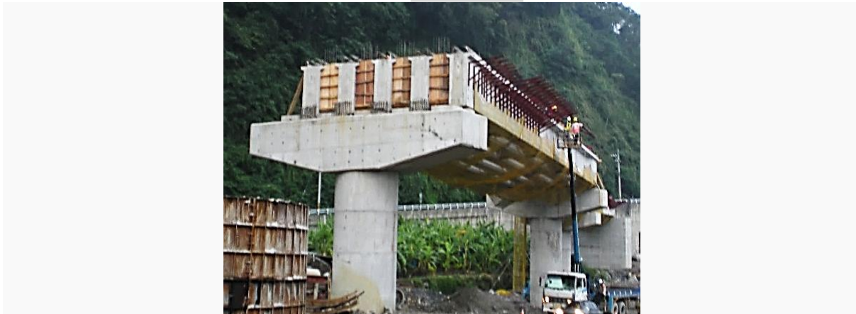
圖 11 端隔梁現場施工圖
