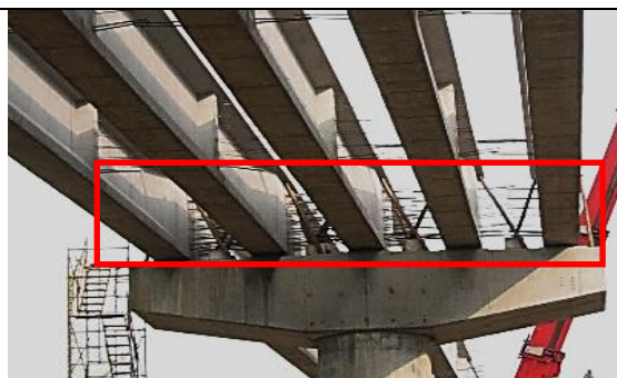
照片 6：吊放後-斜撐只於兩端帽梁
