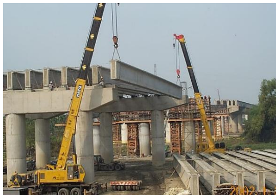
照片 9：預力梁之預鑄與吊放作業
