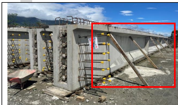
照片 5：吊放前-斜撐可均佈於梁身
