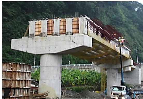
照片 10：預力梁吊放後隔梁施工中
