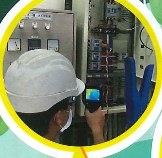
電力盤熱點量測
